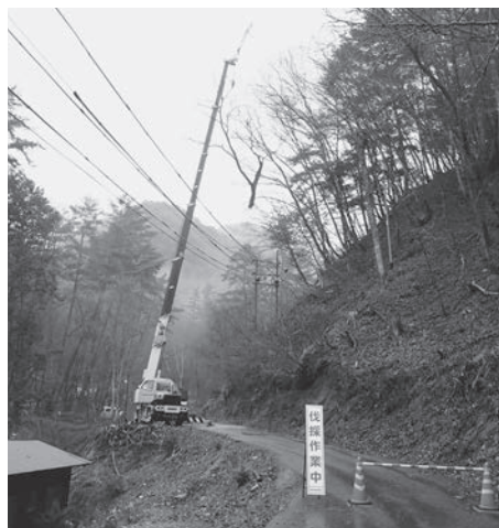
ライフライン沿いの支障木の伐採 (栃城地区)
